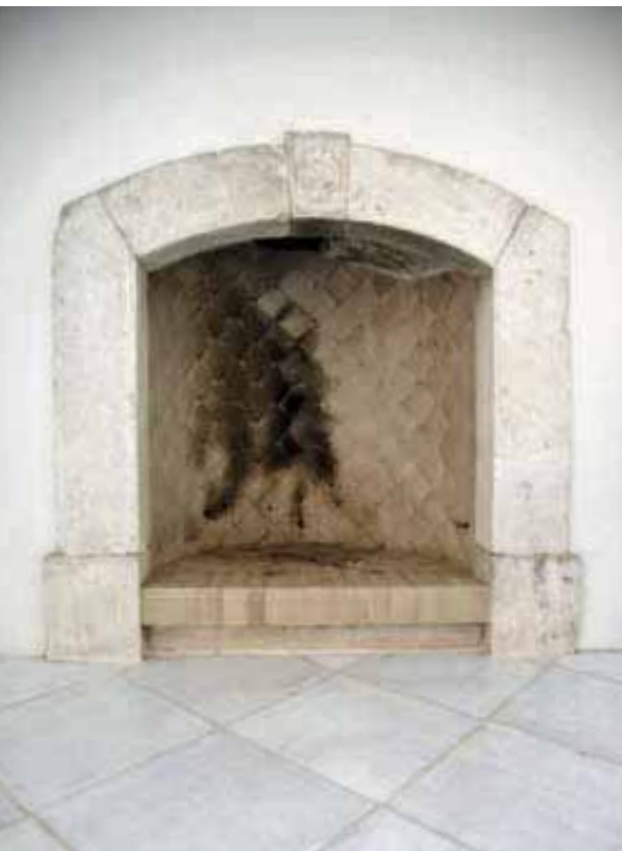
In alto, da sinistra: il disegno delle travi in castagno sul soffitto del soggiorno, le cui pareti sono decorate a mano. La scala avvolgente che collega i diversi piani. Due interventi a parete diventano fonti di luce. In basso, da sinistra: la cucina realizzata in muratura. Il camino costruito con pietre che un tempo erano architrave di una finestra. La cucina che, attraverso una finestra interna, si affaccia sul soggiorno al piano inferiore. I rivestimenti della stanza da bagno in cotto smaltato evidenziano l'alta precisione del lavoro di posa.
